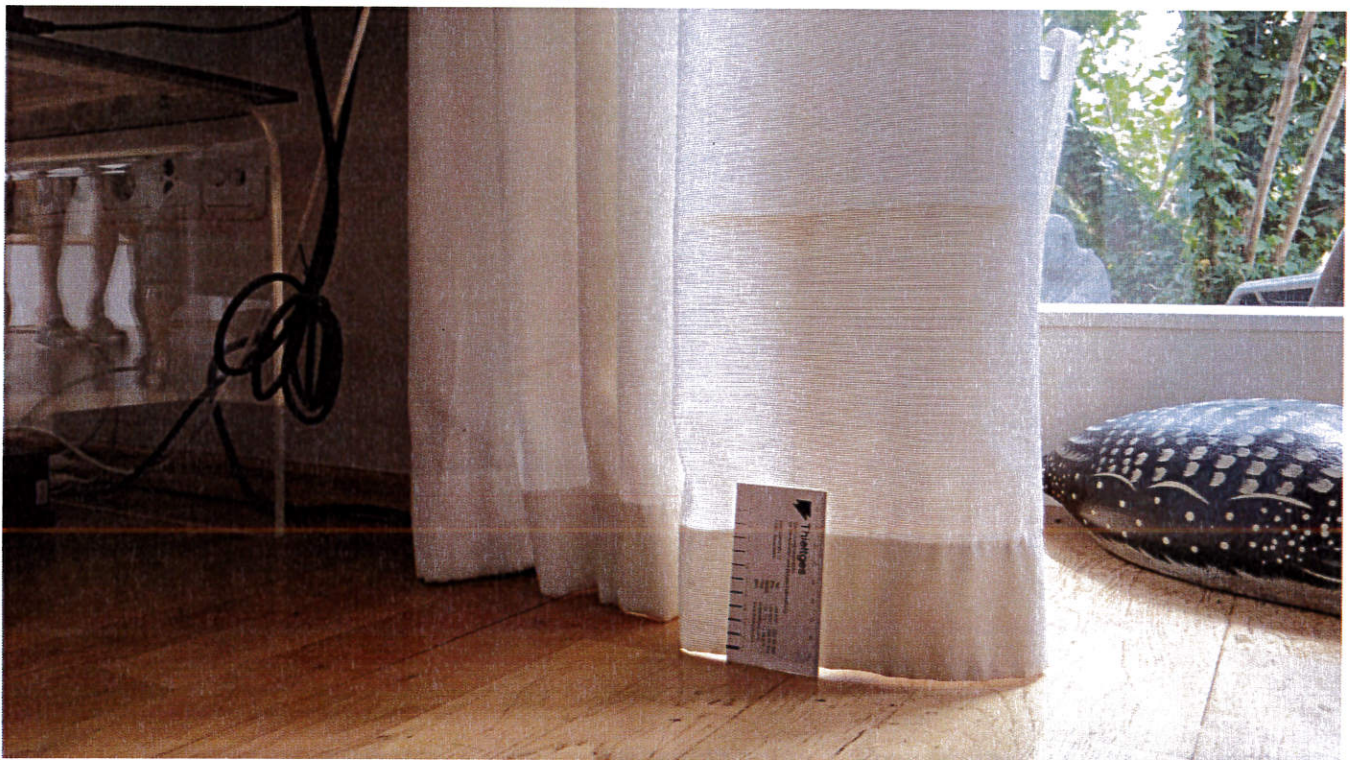
Abb. 17: 13.08.2020 _An den Gardinen im Erdgeschoss zeichnen sich abgetrocknete Feuchteränder in einer Höhe bis zu 30 cm ab.
