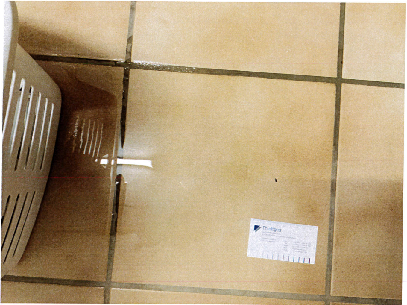
Abb. 14: 13.08.2020 _Der gesamte Fußbodenaufbau ist wassergesättigt.
