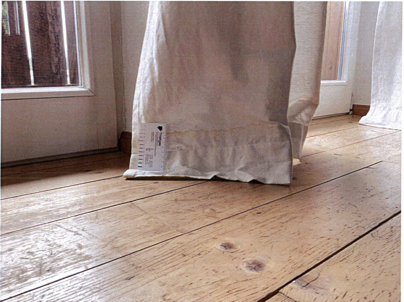
Abb. 22: 13.08.2020 _An den Gardinen im Dachgeschoss zeichnen sich die abgetrockneten Feuchteränder bis zu einer Höhe von 25 cm ab.
