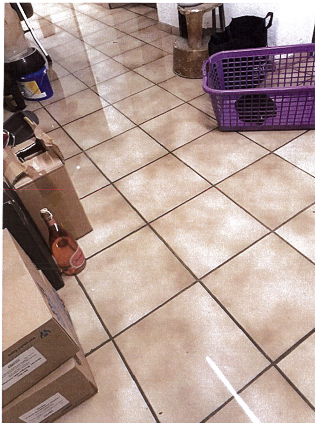
Abb. 12: 28.06.2020 Im gesamten Untergeschoss stand Wasser, bereichsweise bis mehrere cm über OK-Fliesenbelag.
