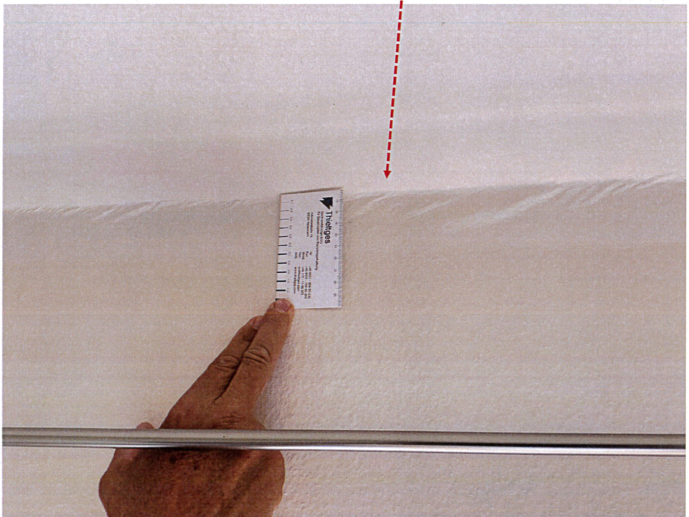
Abb. 20: 13.08.2020 _Das im Dachgeschoss in der Holzbalkendecke versickerte Wasser trat an der Deckenuntersicht über dem OG an den Außenwänden aus.
