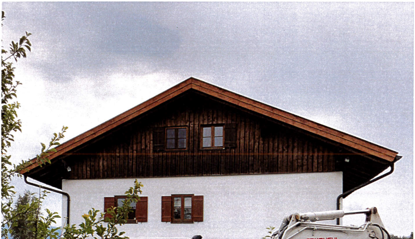
Abb. 7: 13.08.2020_Der Ortgang wurde erneuert. Die Ziegeldeckung bereichsweise ersetzt und repariert.
