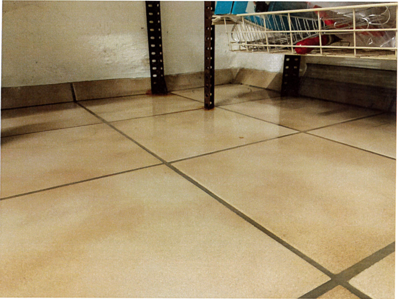
Abb. 13: 13.08.2020 _Im Untergeschoss steht unverändert Wasser auf den Fliesenböden.
