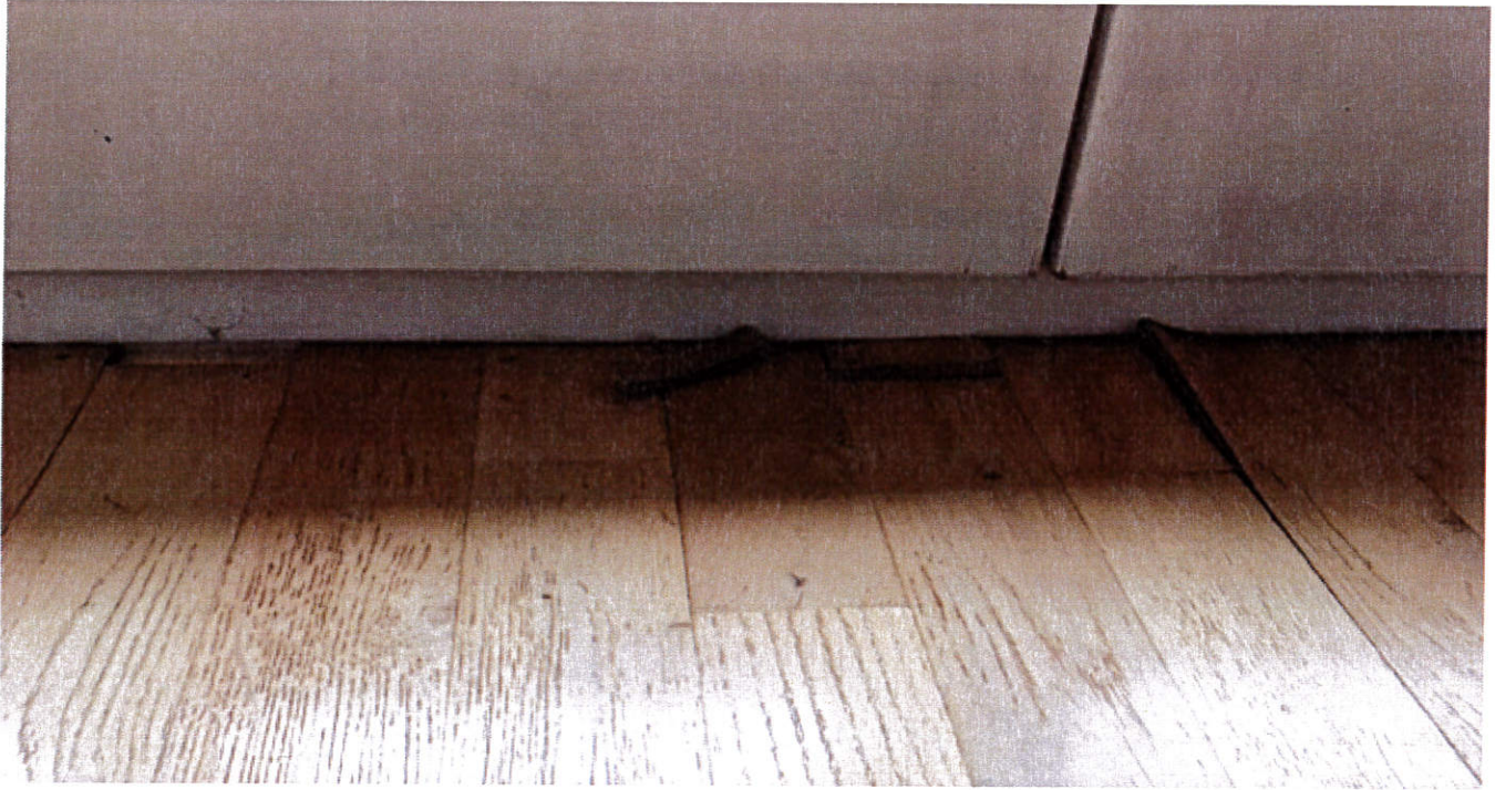
Abb. 16: 28.06.2020_Auf den Parkettböden stand Wasser, das in die Konstruktion der Holzbalkendecken versickerte. Die Parkettböden quellten infolge der Wasserbelastung auf.
