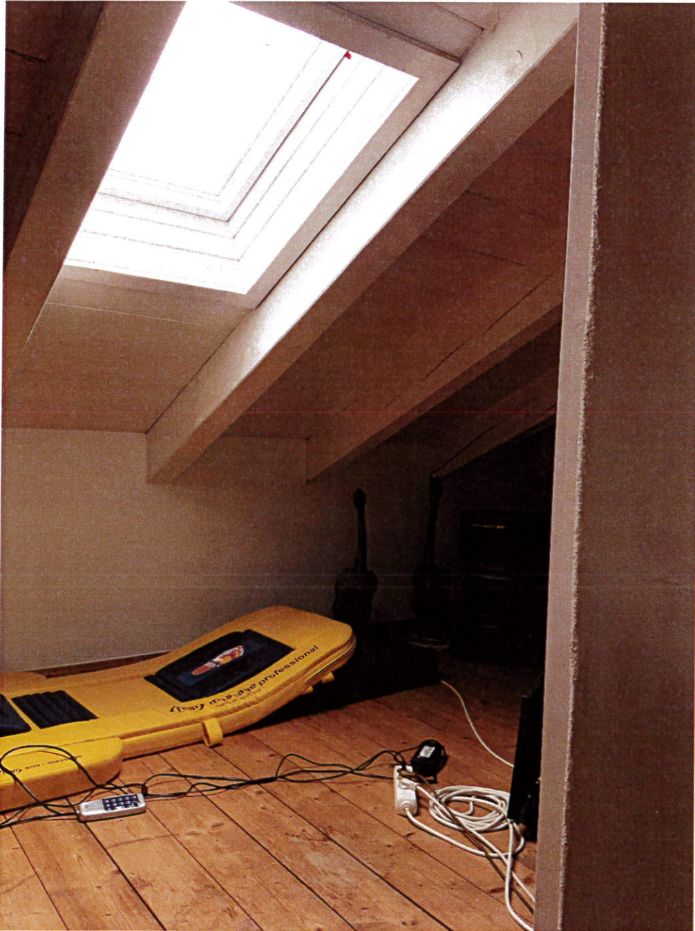
Abb. 23: 13.08.2020 _Wasserablaufspuren am Dachfenster und abgetrocknete Feuchteränder auf dem Holzboden.
