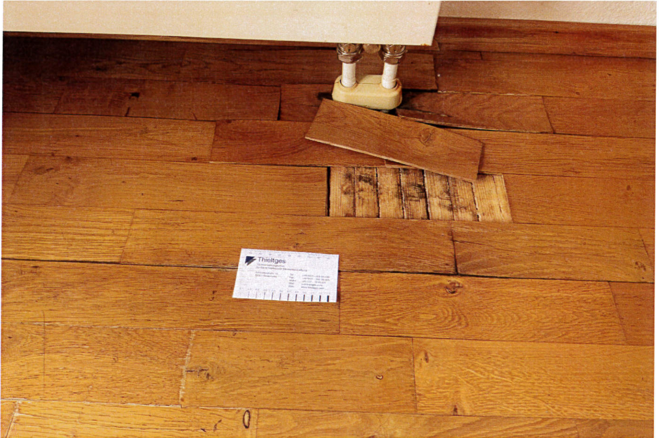
Abb. 18: 13.08.2020 _Die Parkettböden im Obergeschoss sind aufgequollen.
