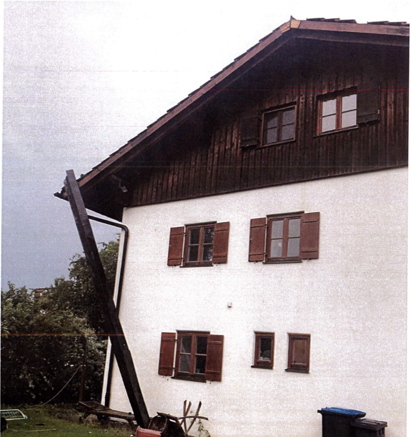
Abb. 5: Die Ortgangverblechungen und –verbretterungen sind heruntergerissen und auf dem Grundstück verteilt (siehe Abb. 6). Im Firstbereich sind die Dachziegel abgedeckt und z.T. heruntergefallen.
